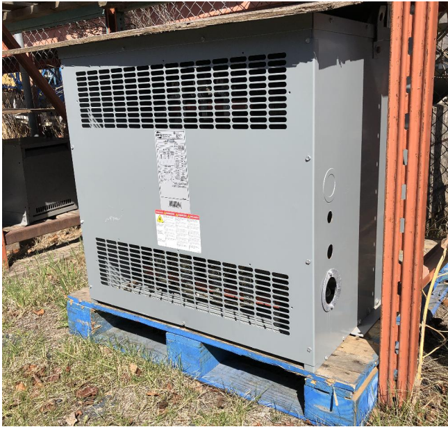
Transformador Hammond HPS de 150 kVA
