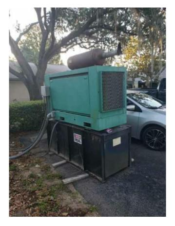
30kW Cummins Diesel Generator
